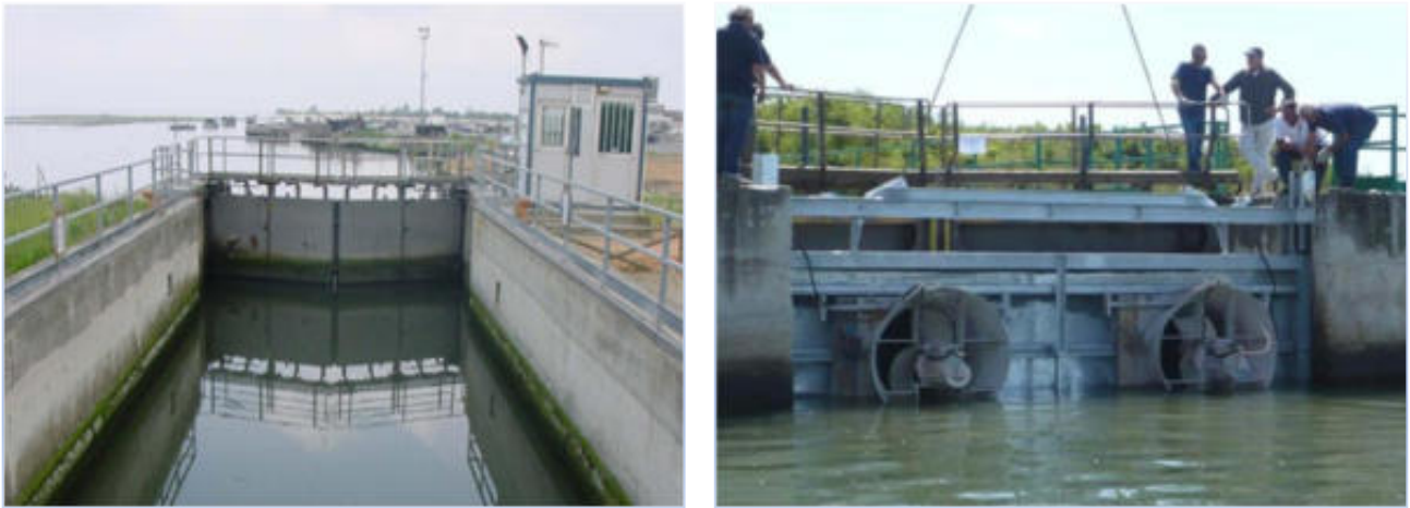
Fig. 4.12 La Conca di navigazione di Gorino, che mette in comunicazione il Po di Goro con la laguna: lavori di installazione delle pompe. (Fonte: Galleria Fotografica – Progetto LIFE AGREE)
